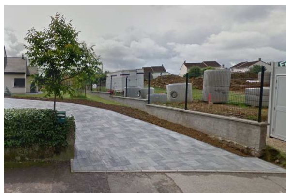
Clôture muret surmontée d'un grillage
