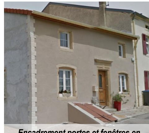
Encadrement portes et fenêtres en pierre de Jaumont, Rue principale Volstroff
