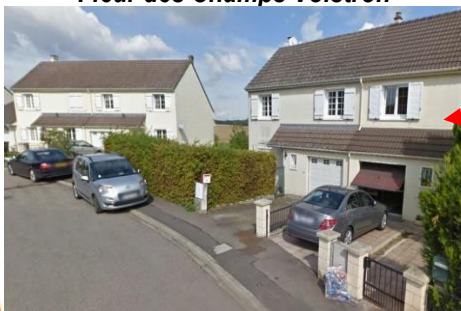
Maison individuelle de type RDC avec décrochement, lotissement la Fleur des Champs Volstroff
