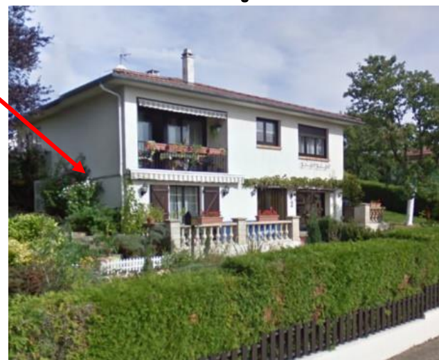
Maison individuelle de type R+1 avec toit à 4 pans, lotissement les Vignes Reinange
